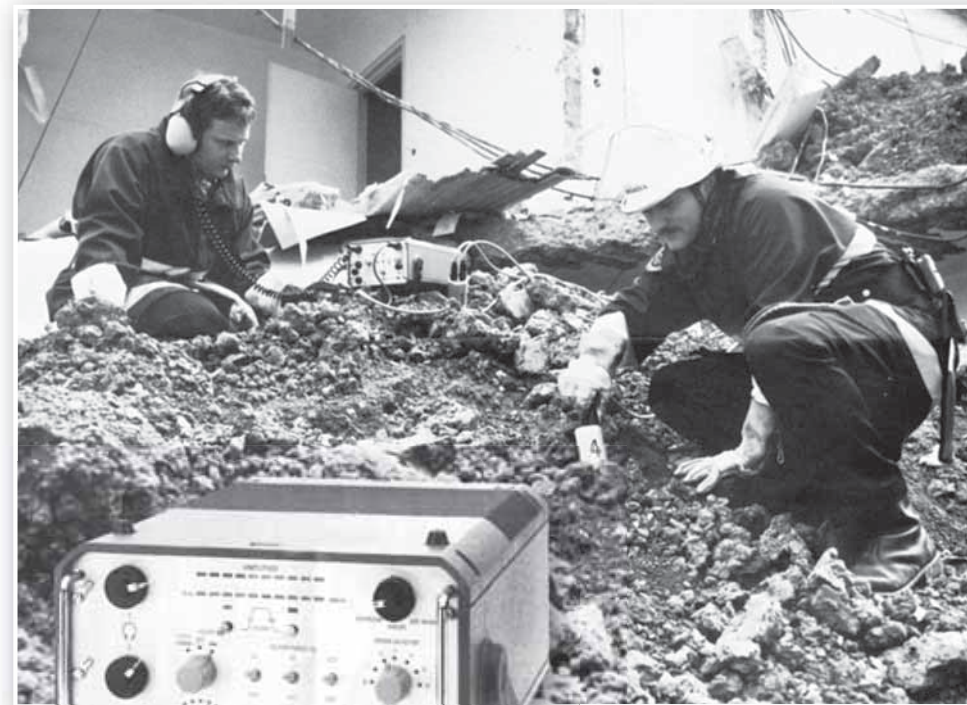
Suche nach verschütteten Personen mit dem Life-Detector.
